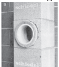
Einbringen einer Dämmatte, so dass die freie Beweglichkeit gewährleistet ist.
