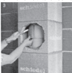
Schiedel Dämmatte mit Messer durchschneiden und entfernen.
