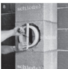
Mit Draht Zarge am Innenrohr anpressen und ausquellenden Kitt verstreichen.
