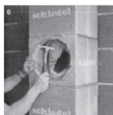
Schamotteteile vorsichtig entfernen.
