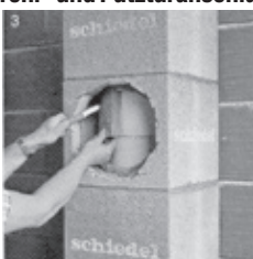
Schiedel Dämmatte mit Messer durchschneiden und entfernen.
