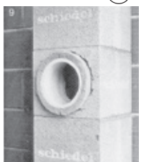
Einbringen einer Dämmatte, so dass die freie Beweglichkeit gewährleistet ist.
