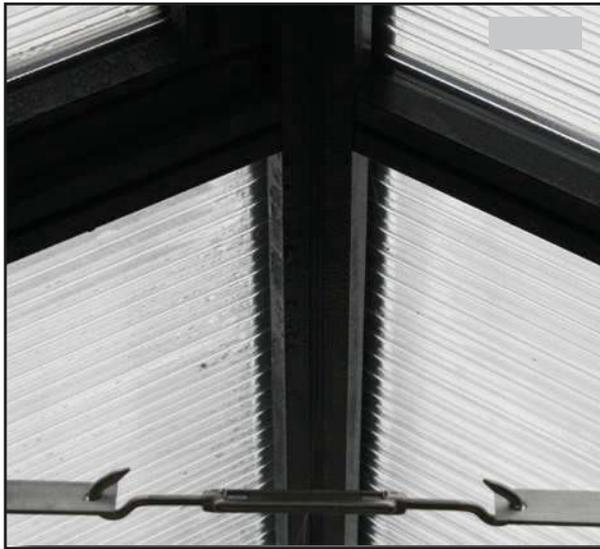
Um eine optimale Unterstützung des Firstprofils zu erreichen, wird die Spannschlossarretierung mithilfe eines Schraubendrehers bis zur gewünschten Spannung gedreht.
