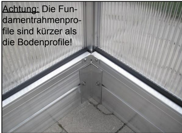
**Achtung:** Die Fundamentrahmenprofile sind kürzer als die Bodenprofile!
