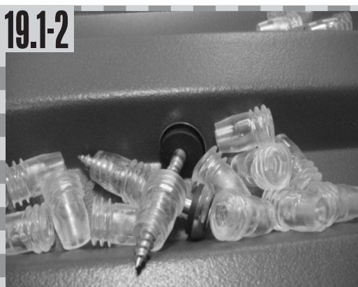
Abstandshalter und Schrauben auf der Bedachungsplatte ablegen
