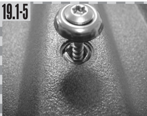
Spenglerschraube setzen...
